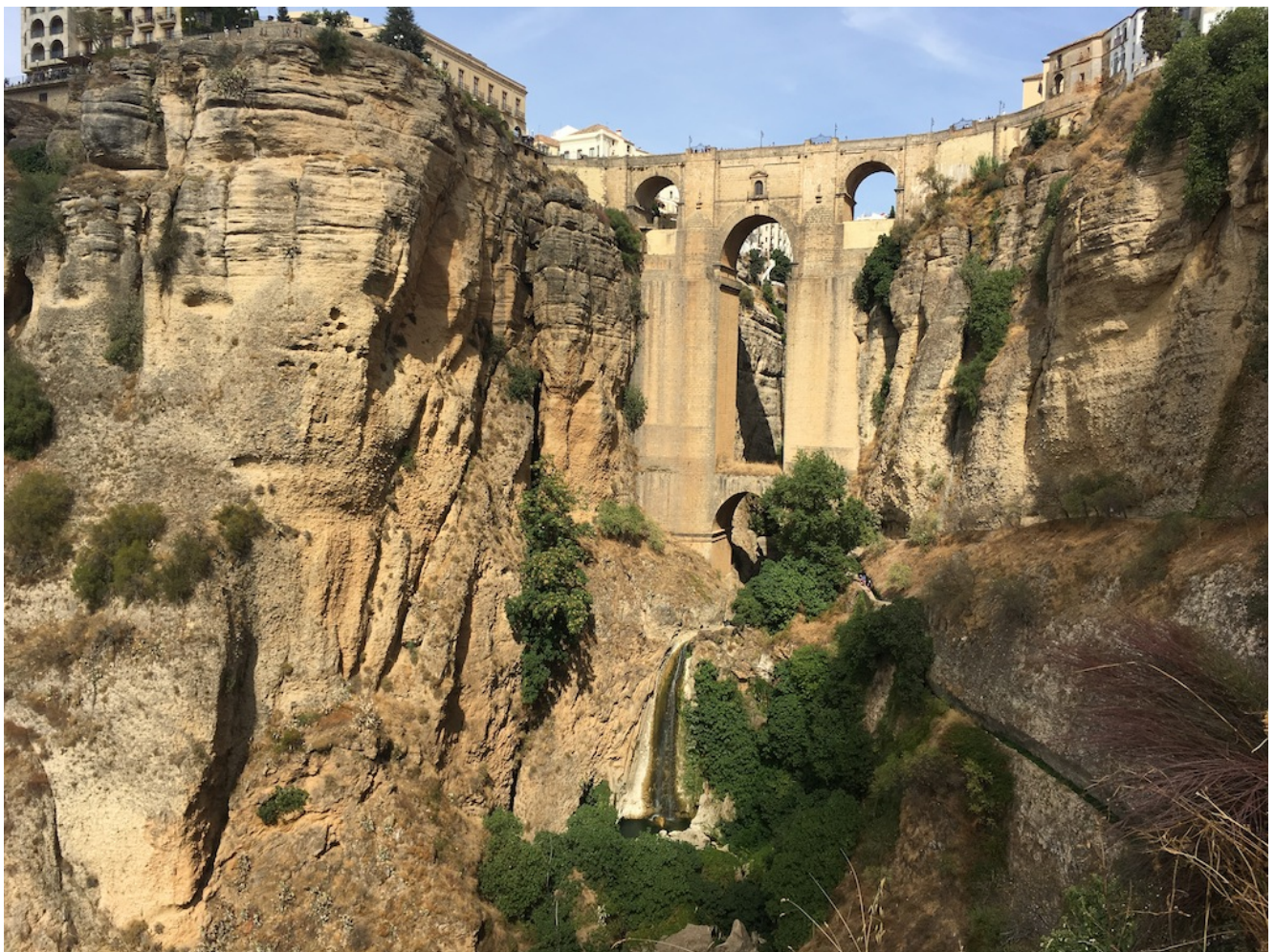
Puente Nuevo de Ronda
