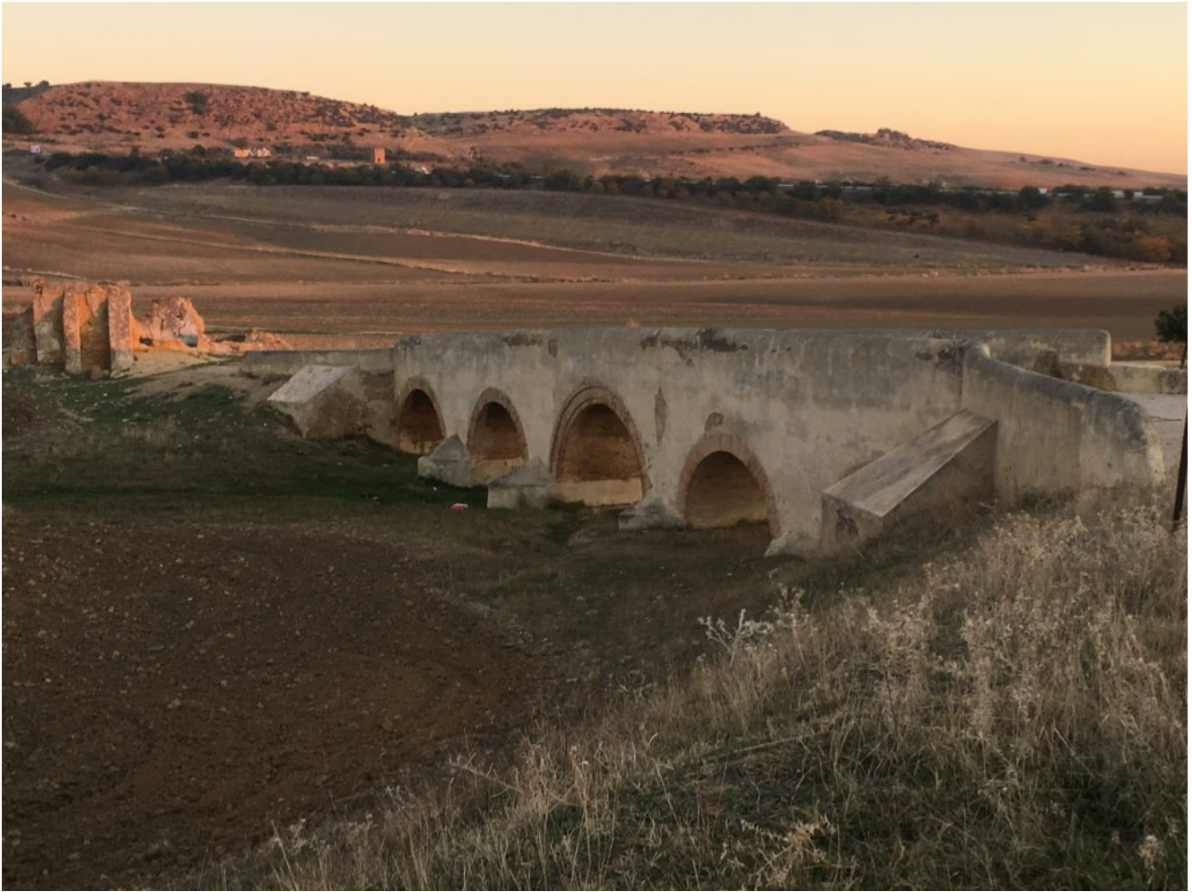
Puente de los Cinco Ojos
