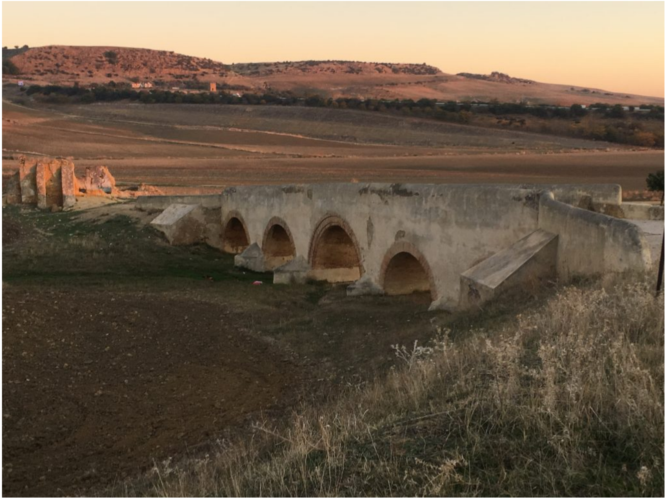
Puente de los Cinco Ojos
