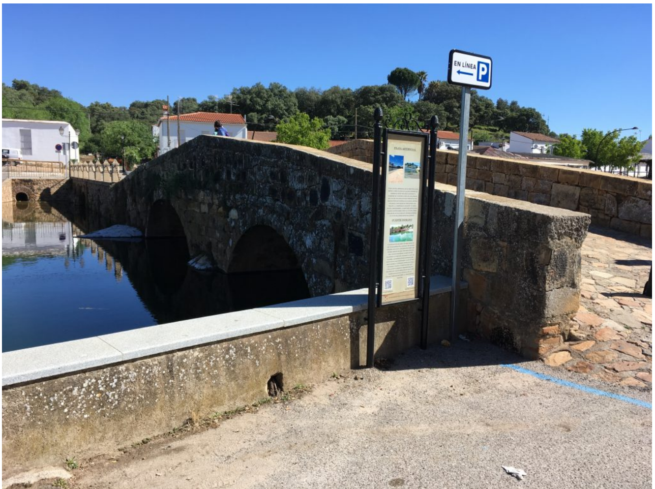
Puente Romano de Piedra
