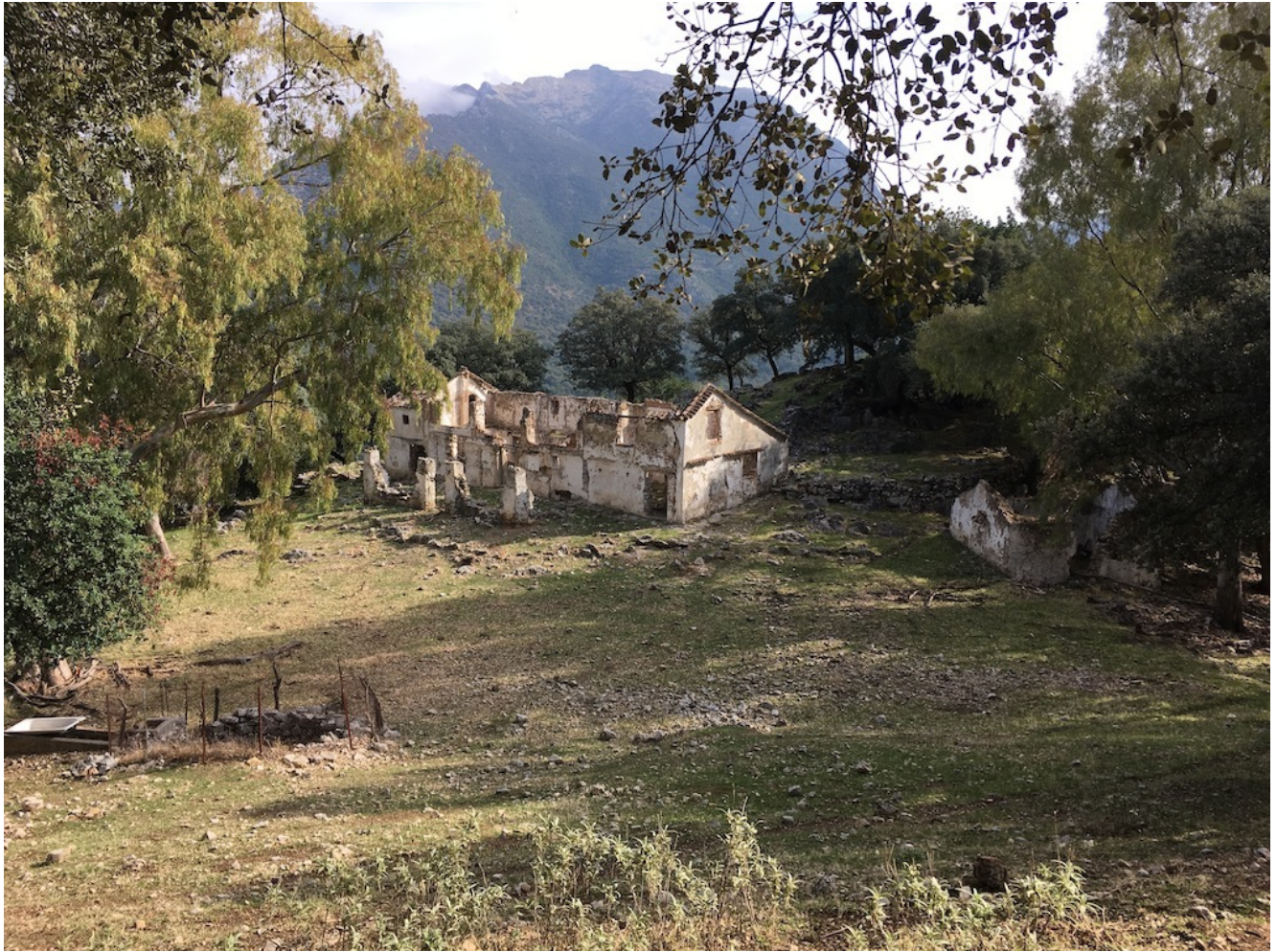
Casa en ruinas
