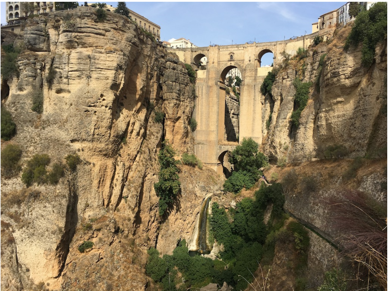
Puente Nuevo de Ronda
