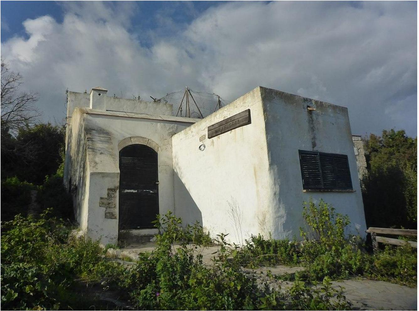
Su construcción seguía el mismo patrón. Una torre sólida de poca altura con paredes gruesas que se adaptaba a los fuertes vientos. Los muros se realizaban en mampostería y llegaban a tener hasta 1,5 metros de altura. El techo era de madera con una capa de zinc y se apoyaba en una estructura que le permitía rotar para poder orientar las ocho aspas hacia donde soplase el viento.
