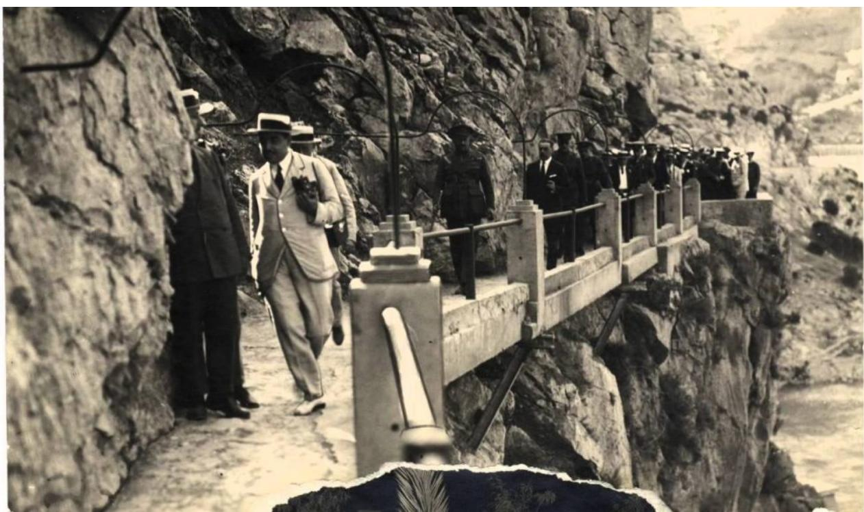
Primero vamos a hacer un poco de historia sobre el Caminito del Rey: Este sendero se construyó porque la Sociedad Hidroeléctrica del Chorro, propietaria del Salto del Gaitanejo y del Salto del Chorro, necesitaba un acceso entre ambos “saltos de agua” para facilitar tanto el paso de los operarios de mantenimiento como el transporte de materiales y la vigilancia de los mismos.
