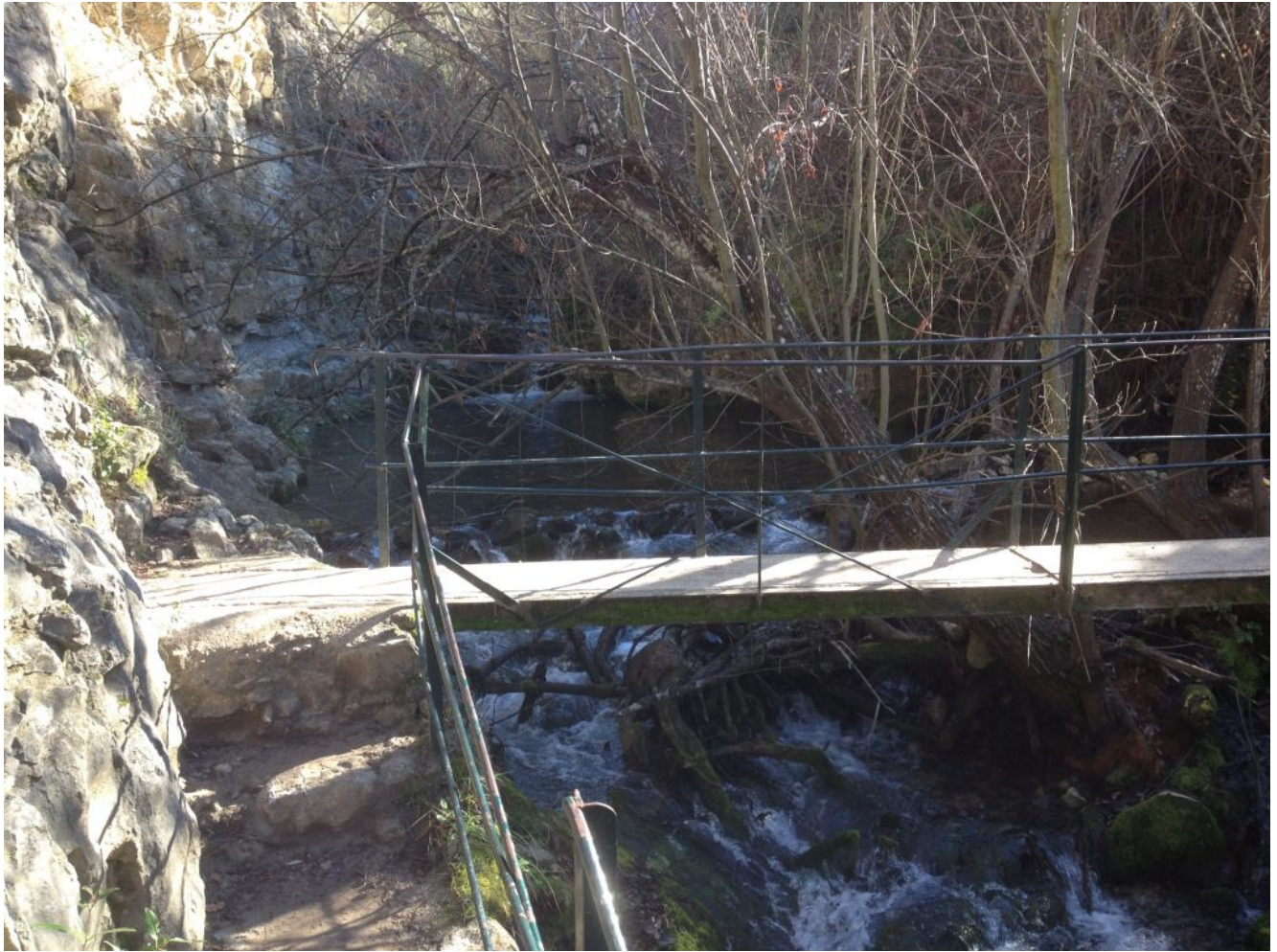
Puente sobre el río
