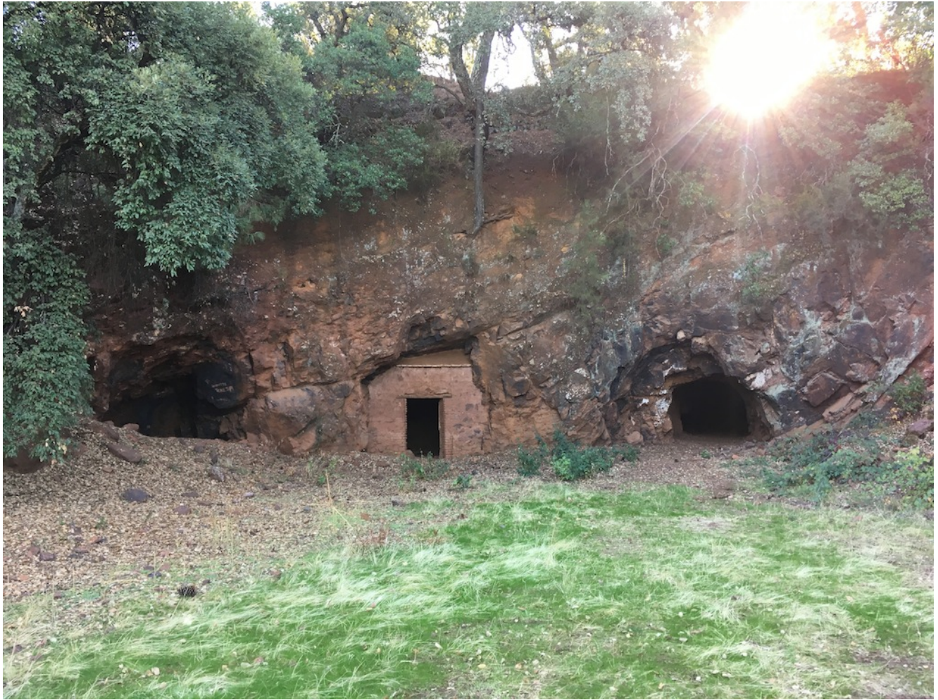
Entrada a las minas
