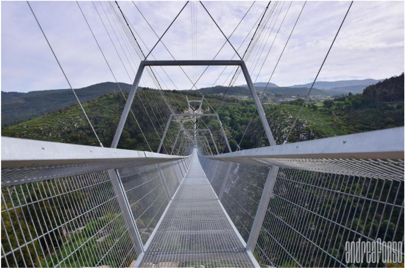
El puente de cristal de los pasajes del Paiva es una estructura de 516 metros (la mayor del mundo). De uso sólo peatonal, el puente está suspendido a 150 metros de altura junto al geositio de la Cascada de Agúeiras y en las inmediaciones de la escarpa conocida como la Garganta del Paiva. Inspirada en los puentes incas que atravesaron los profundos valles de la Cordillera de los Andes.
